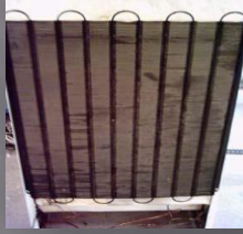
Συμπυκνωτής φυσικής κυκλοφορίας οικιακού ψυγείου
