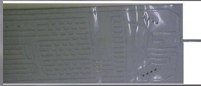
Εξατμιστής οικιακού ψυγείου τύπου πλάκας
